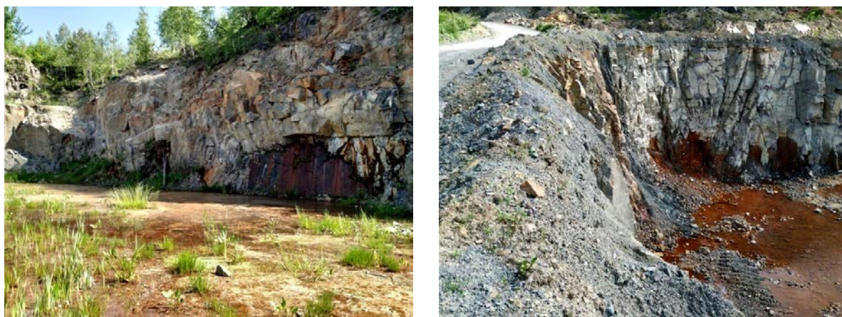
Рис. 4. Фільтраційні потоки з кристалічних порід до Вирівського гранітного кар'єру
