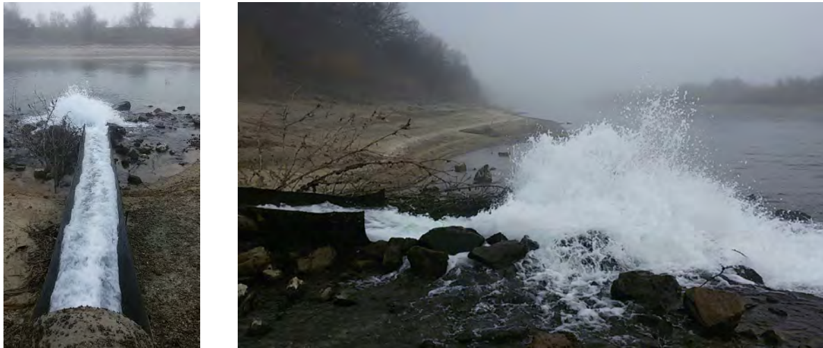
Рис. 1. Дренажне гирло на Північно-Кримському каналі на пікеті 259 (14.12.2019 р.)
