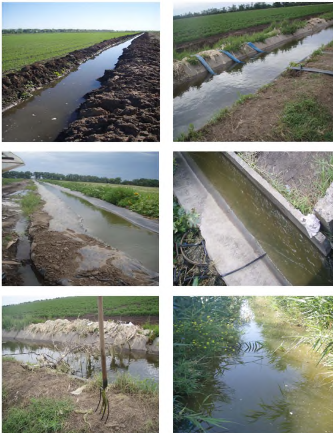
Рис. 1 Підвідні канали внутрішньогосподарської зрошувальної мережі на дослідних ділянках
